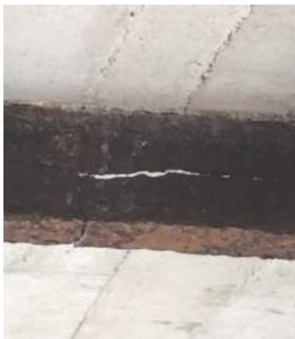
**Figura 2.** Detalle de rotura por corrosión de uno de los rieles. Fotografía: Soledad Díaz.
