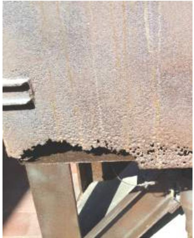
**Figura 6.** Ampliación del detalle de la corrosión por escorrentía con pérdida de material perdida. Fotografía: Soledad Díaz.
