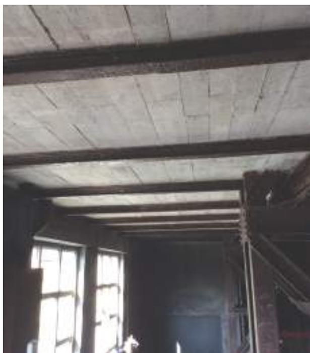
**Figura 1.** Detalle de la utilización estructural de los rieles de las vagonetas. Fotografía: Soledad Díaz.
