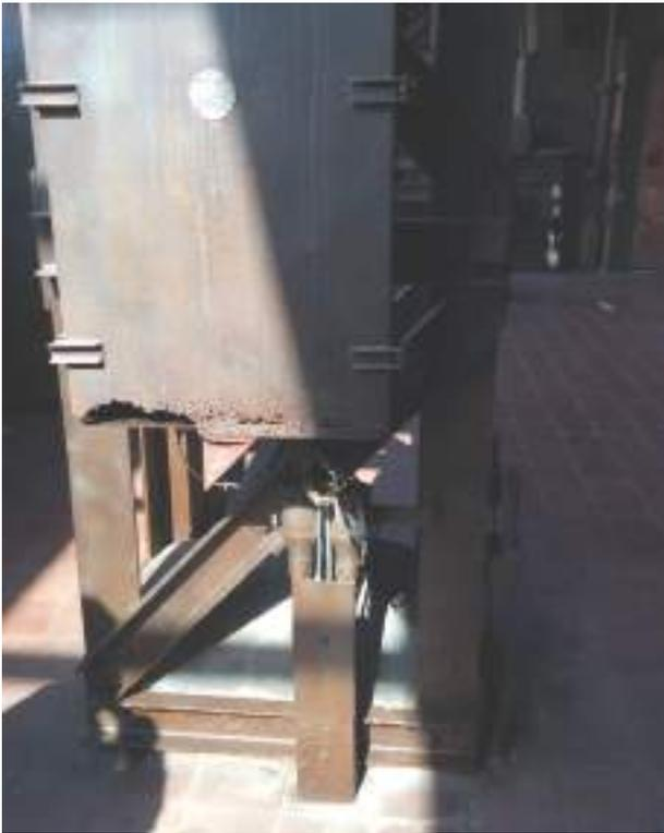
**Figura 5.** Elemento corroído debido a la escorrentía que se produce por condensación en un panel sin capa protectora (recubrimiento de pintura). Fotografía: Soledad Díaz.
