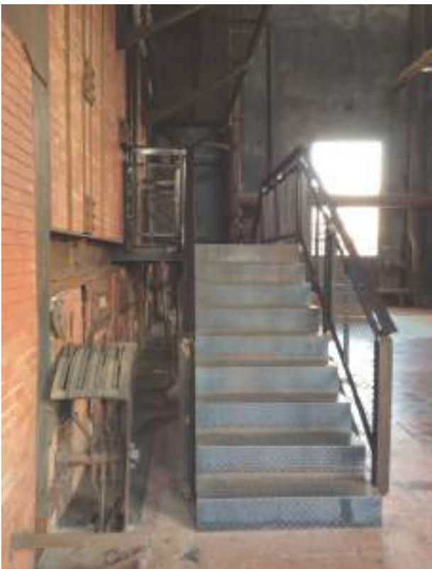
**Figura 7.** Escaleras metálicas de nueva factura para facilitar la accesibilidad. Fotografía: Soledad Díaz.
