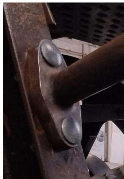
Montaje de la escalera de acceso apoyada sobre un cajón metálico, que suplementa la antigua disposición del foso de mantenimiento.
