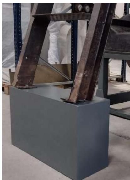
Montaje de la escalera de acceso apoyada sobre un cajón metálico, que suplementa la antigua disposición del foso de mantenimiento.
