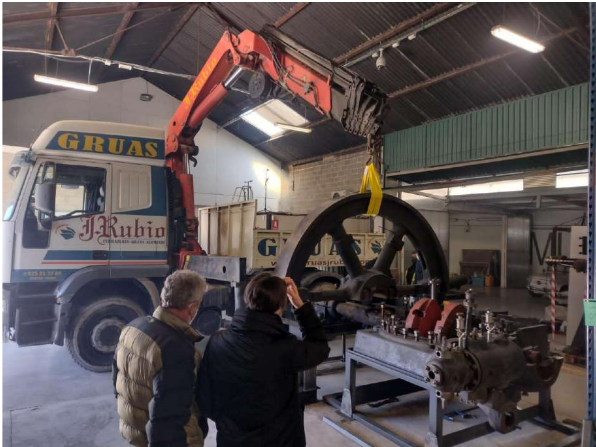
Instalación del medio volante de inercia sobre su bancada de perfilería metálica.
