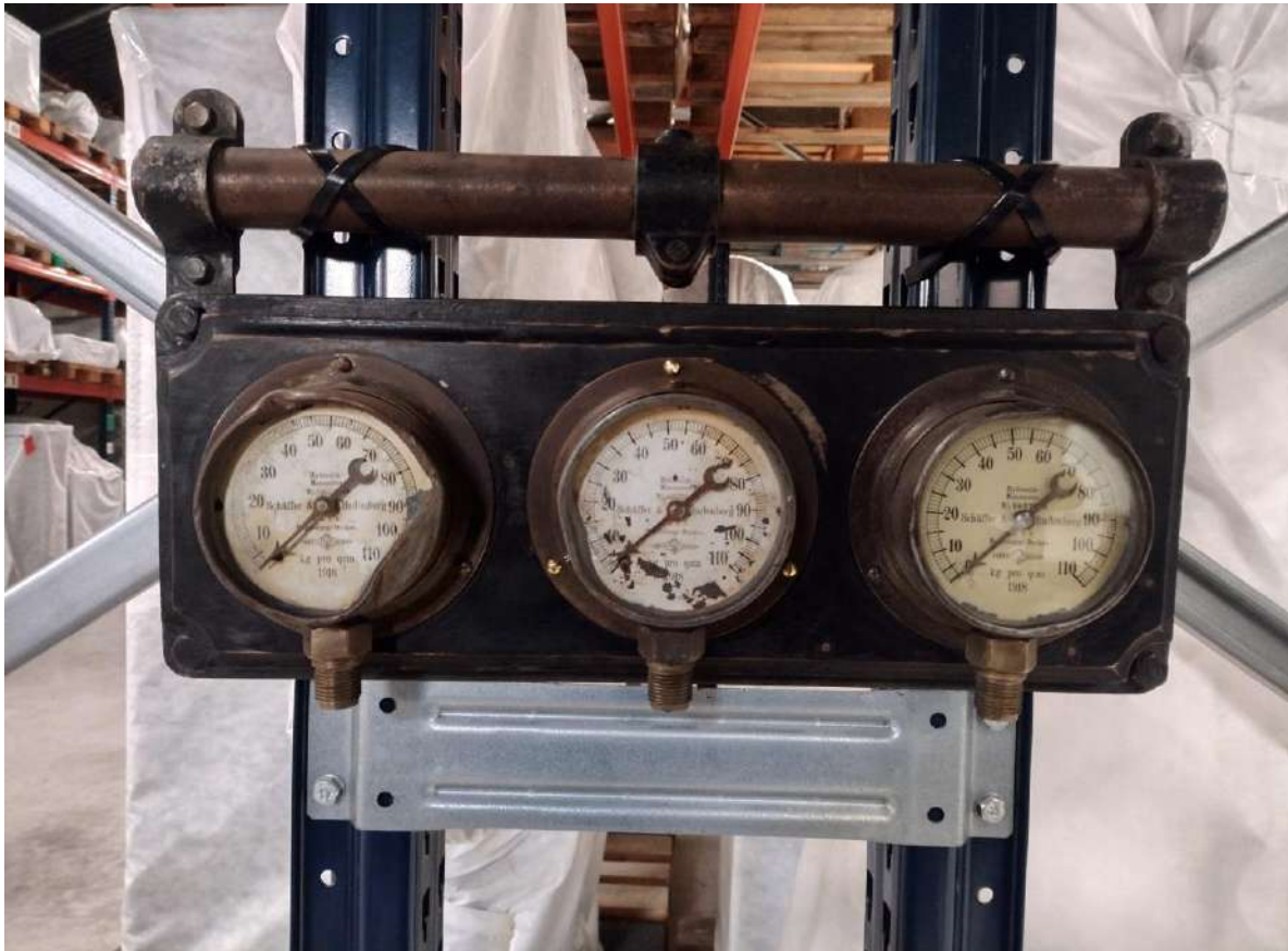
La instalación del panel de mandos se realiza en la estantería próxima al motor.
