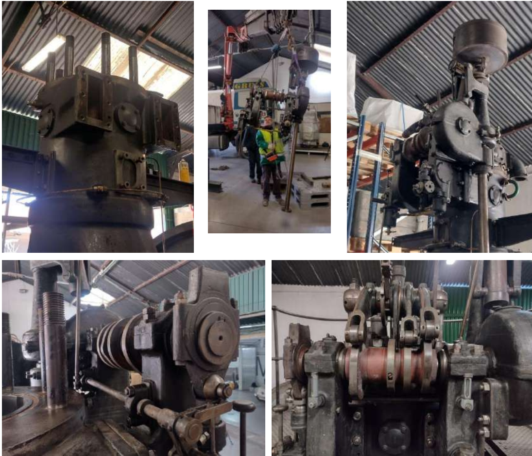
Proceso de montaje del árbol de levas.
